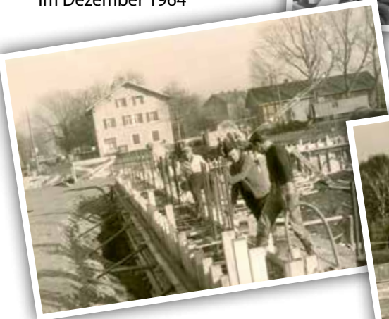
Die Großbaustelle im Dezember 1964
